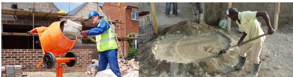
Figura 5 – Exemplo de concreto dosado em obra. Fonte: (WE CIVIL ENGINEERS, 2018).
