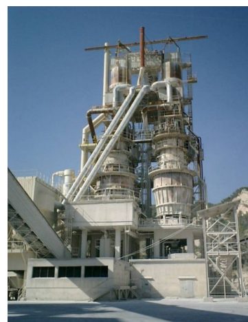
Figura 4 – Forno vertical de fluxo paralelo regenerativo (tipo Maerz) (fonte: LHOIST, 2022).
