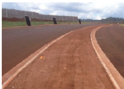
(c) Execução de passeios públicos.
