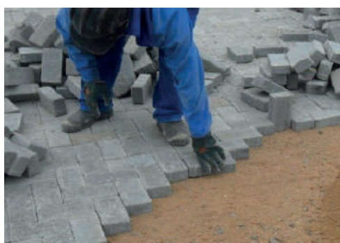
(b) Camada para assentamento de pavimento intertravado.
