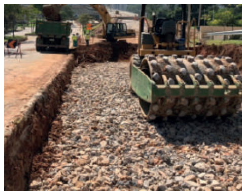
(a) Uso em pavimentação, nas camadas de base, sub-base ou reforço do subleito.
