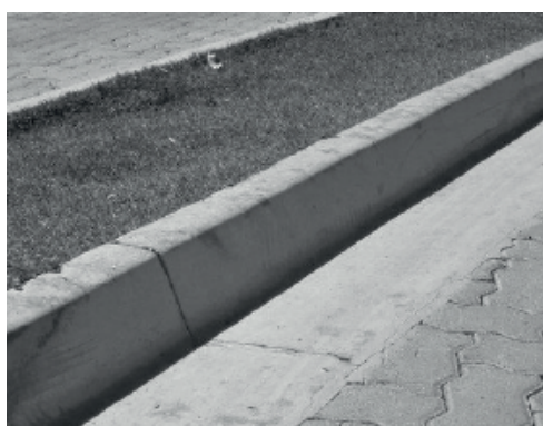
(d) Execução de sarjetas e guias em concreto moldado in loco.
